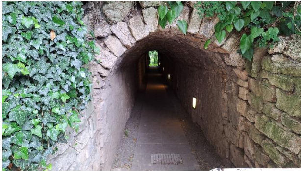
Abb. 4: Zugangstunnel. Foto: Miriam Compes (MC)
